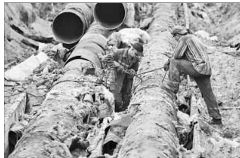
■ В преддверии отопительного сезона в городе активно ремонтировали теплотрассы.
